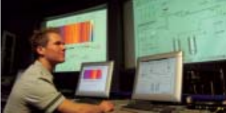
Sala de control
